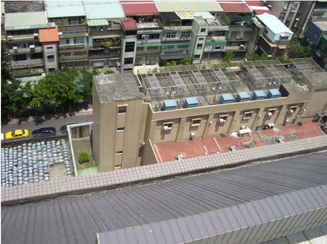
延壽街 319 號變電所位置照片(二)
