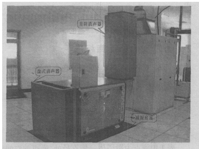
图 1 风机安装消声器后的外观图
